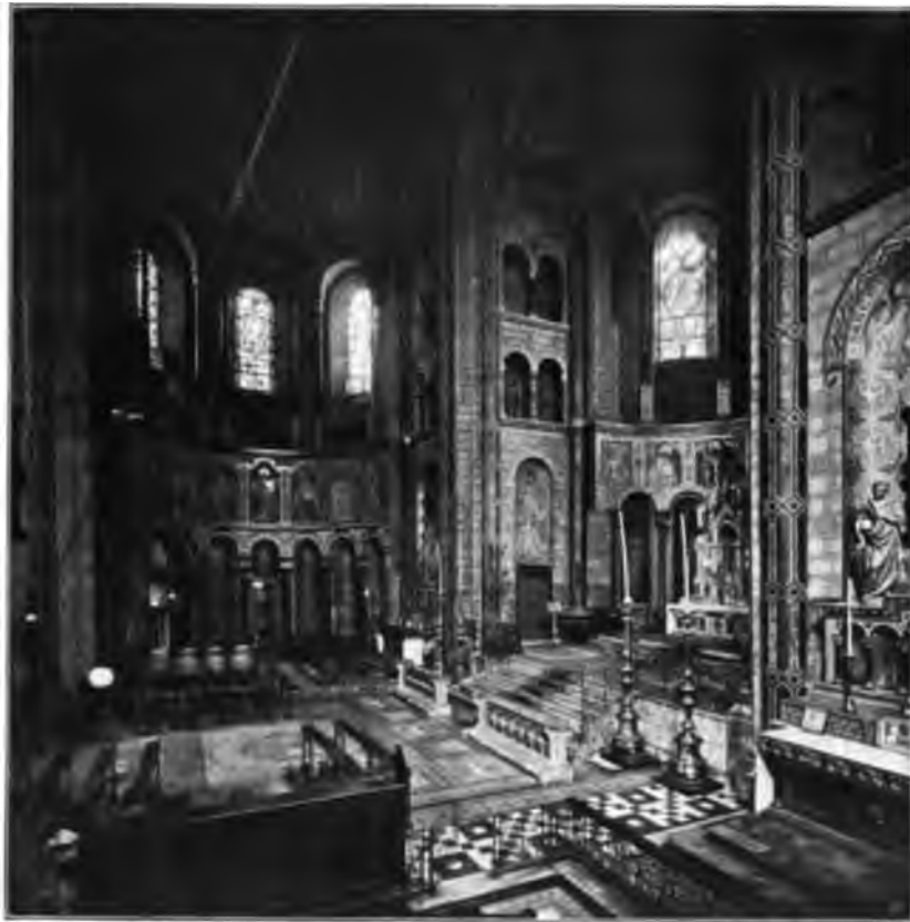
Intérieur du chœur de Saint-Martin-le-Grand.
